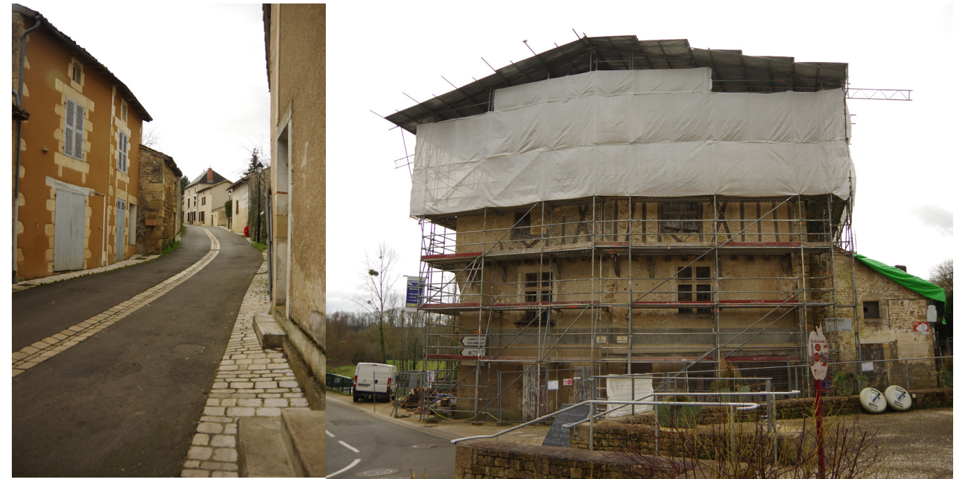
Ruelles étroites et maison ancienne dans le centre bourg de Jazeneuil
